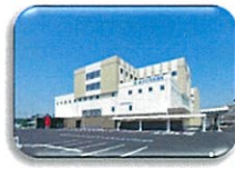
あがの市民病院外観
